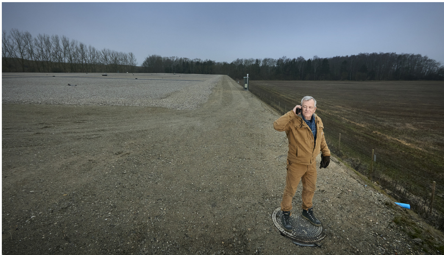
VEKS' og Høje Taastrup Fjernvarmes varmelager gik i kommerciel drift i februar 2023
